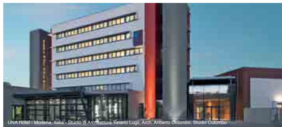
UNA Hotel - Modena, Italia - Studio di Architettura Tiziano Lugli; Arch. Ariberto Colombo, Studio Colombo
